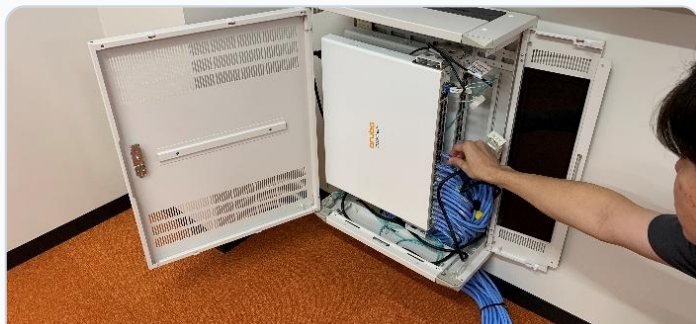
ネットワーク機器の調整作業
